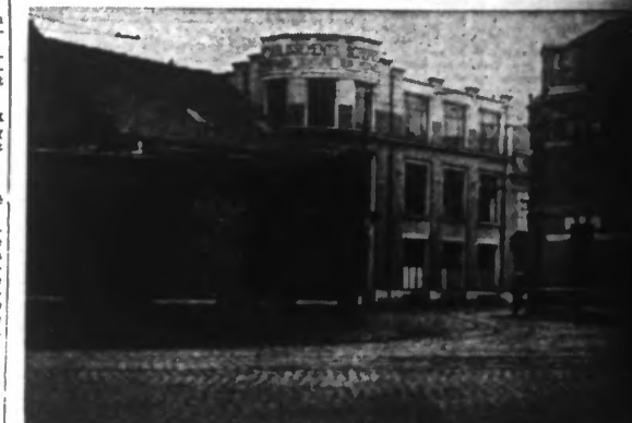
Le DANGEREUX CARREFOUR A L'ENTRÉE DE LA RUE DU COQ-FRANÇAIS ET QUI DÉBOUCHE BOULEVARD GAMBETTA, VA ÊTRE BIEN TÔT DÉGAGÉ.
