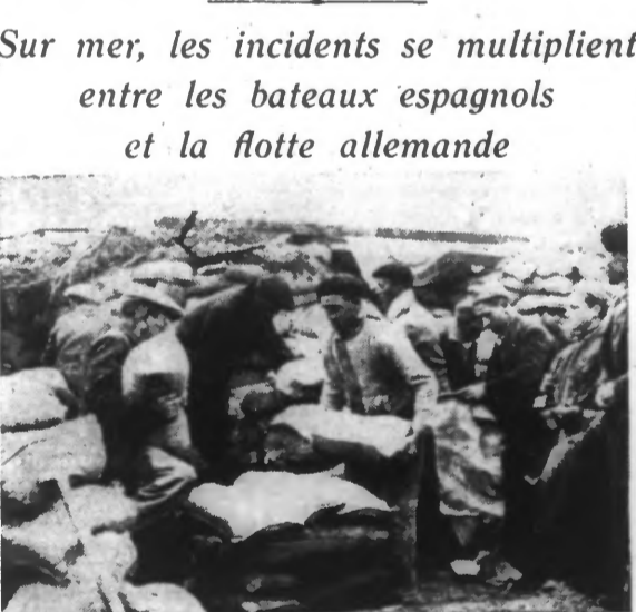
LA DISTRIBUTION DE SACS DE SABLE DESTINÉS AUX TALLS DES TRANCHÉES QUE LES GOUVERNEMENTAUX MULTIPLIENT DANS LES RUES DE MADRID.
