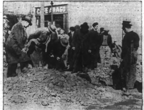
Sous la direction des ingénieurs, on recherche l'origine de la fuite de gaz qui a causé l'accident. (Ph. N.Y.T.)
