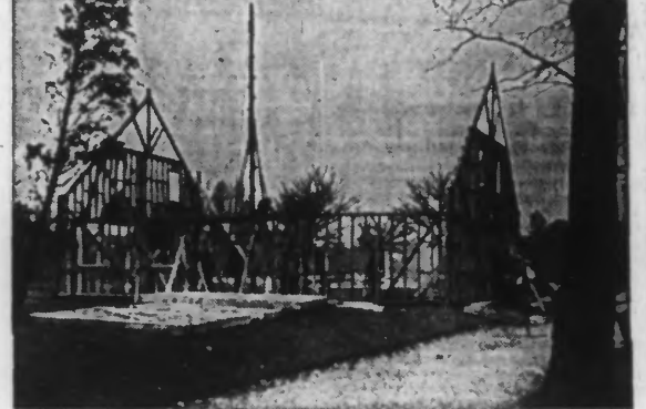
LE PAVILLON DES VOSGES (Ph. J. de R.) en construction près de la piste cyclable de l'avenue Le Nôtre.
