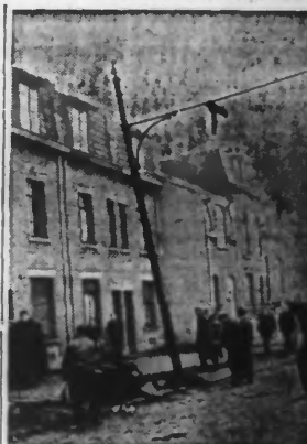
LE PYLÔNE SUR LEQUEL L'AUTOBUS EST ALLÉ SE JETER, AVANT DE S'ENFLAMMER. (Ph. J. de Bx.)
