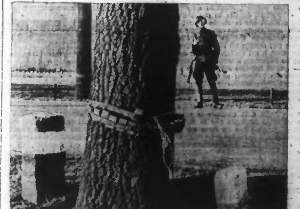
A la frontière germano-hollandaise, cet arbre, gardé par une sentinelle, est entouré d'une ceinture d'explosifs. A la moindre alerte, un dispositif provoquerait l'explosion et l'arbre tomberait en travers de la route, empêchant toute circulation. (Ph. France-Press.)
