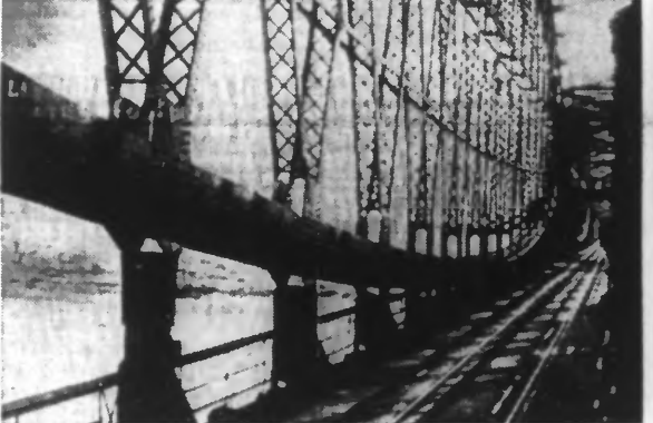
Le pont sur la Vistule où passe la voie ferrée qui relie le Reich au territoire de Dantzig, à travers le « corridor » polonais. (Ph. Safra.)
