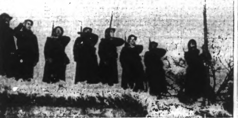
Ph. France Presse (N° 35.721). La commot d'un ouvrage bétonné, la garnison salua les trois couleurs.
