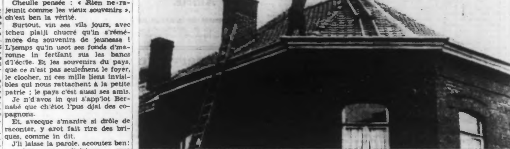
Tout le monde se souvient encore du cyclone du mois de novembre dernier, qui causa tant de dégâts aux cheminées et aux toits. Avec les premiers beaux jours, les couvreurs se sont mis à l'ouvrage pour réparer les dommages qui ne s'étaient pas encore cicatrisés.
