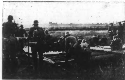
Des pionniers allemands construisent un pont de secours qui sera lancé sur une petite rivière. (Ph. Belgapresse)
