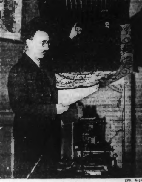
Après dix ans de recherches, un ingénieur français, M. François Savoit, a construit un appareil qui permettra la projection en relief, sans obliger les spectateurs au port de lunettes.
