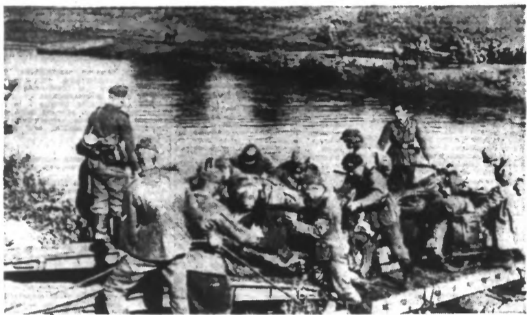
Passage d'un cours d'eau sur un pont de fortune dans le secteur méridional.
