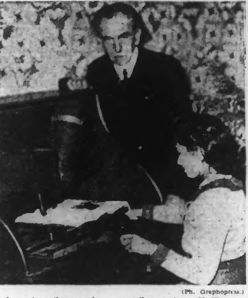
Le « phono-électrographe », appareil construit par M. Thomas, permet aux aveugles de lire immédiatement au toucher tous livres, journaux et manuscrits qu'ils désirent.
