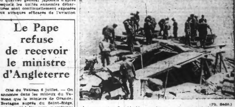
La construction d'un blockhaus en béton, sur la côte de la Méditerranée.
